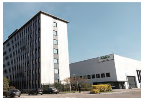
Headquarters (Italy) 本社 (イタリア)
